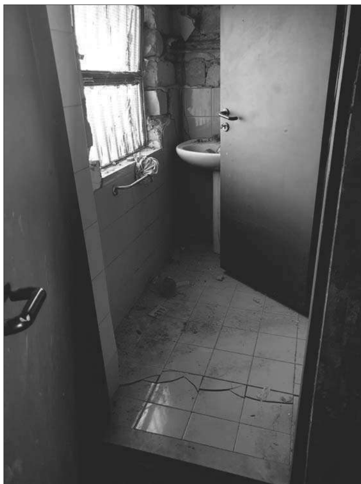
FOTO 12: SERVIZIO IGIENICO - LESIONI SUL PAVIMENTO
