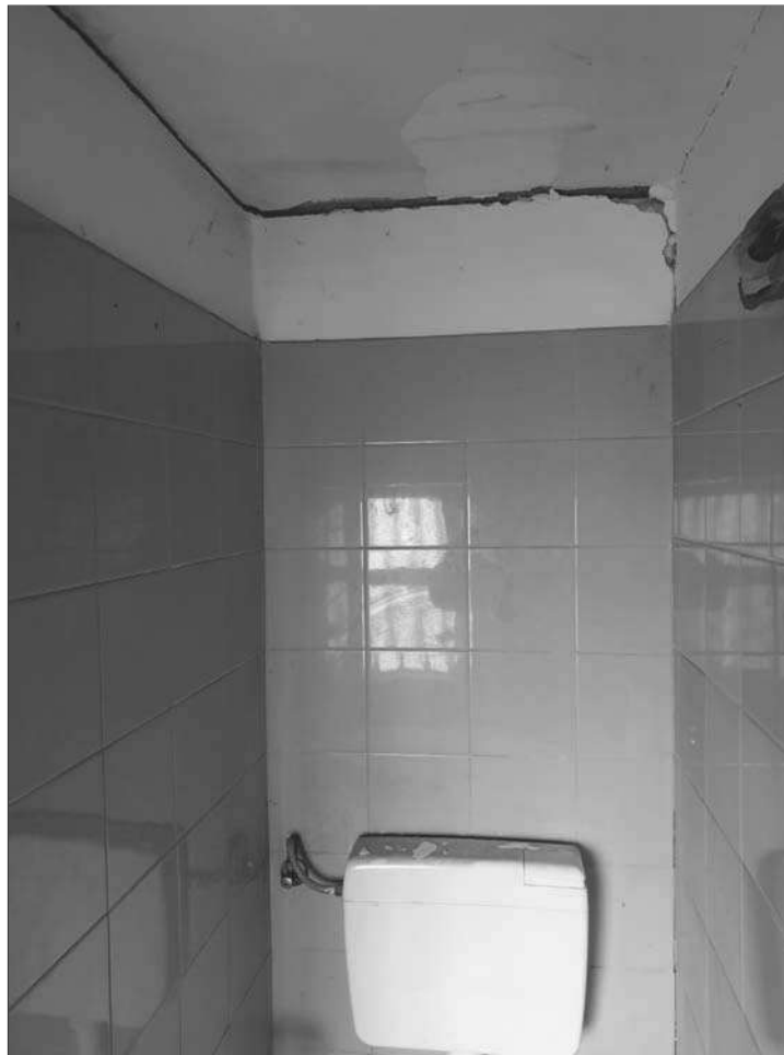
FOTO 17: W.C. - DISTACCO DELLA MURATURA DALLA SOLETTA PUNTELLATA
