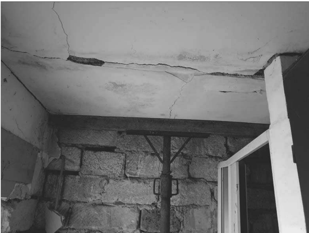
FOTO 14: SERVIZIO IGIENICO - LESIONI SU MURI E SU SOLETTA DI COPERTURA. PUNTELLO A SOSTENO DELLA SOLETTA.
