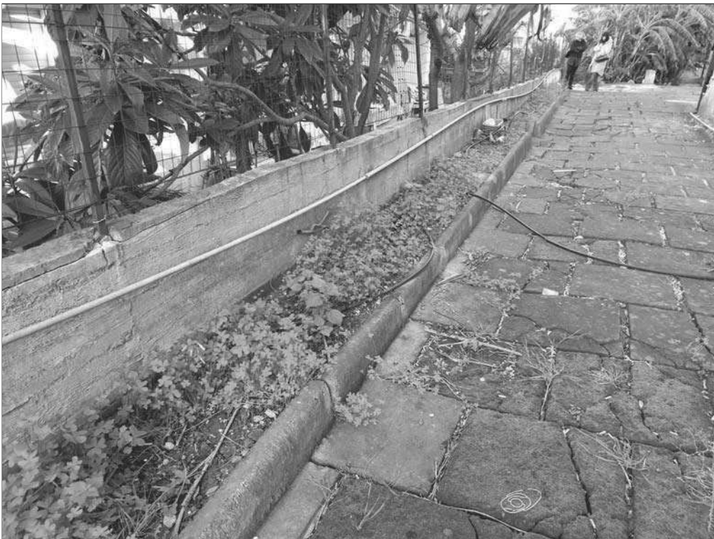
FOTO 24: MURETTO DI CONTENIMENTO SPINTO E RUOTATO VERSO L'ESTERNO
